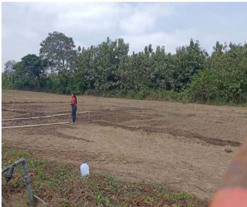
Figura 5. Instalando el sistema de riego Vallejo, 2023
