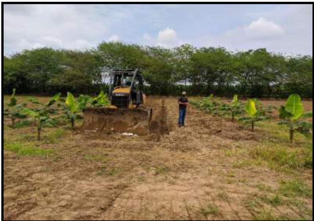
Figura 30. Preparación del terreno Toala, 2022
