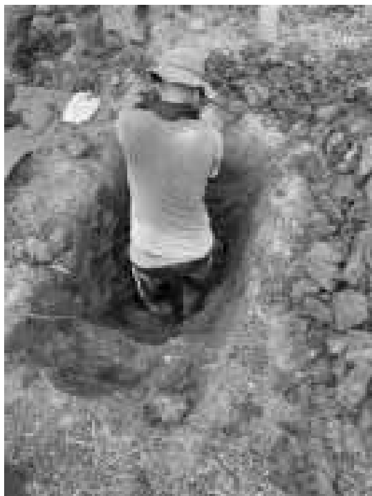
Ilustración 1. Excavación para Instalación de Freatímetros
