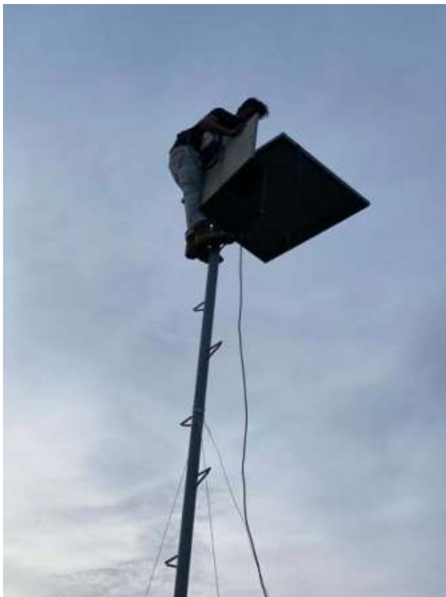
Figura 25. Realizando la instalación de los equipos en la finca - 4 Silva y Soto, 2023
