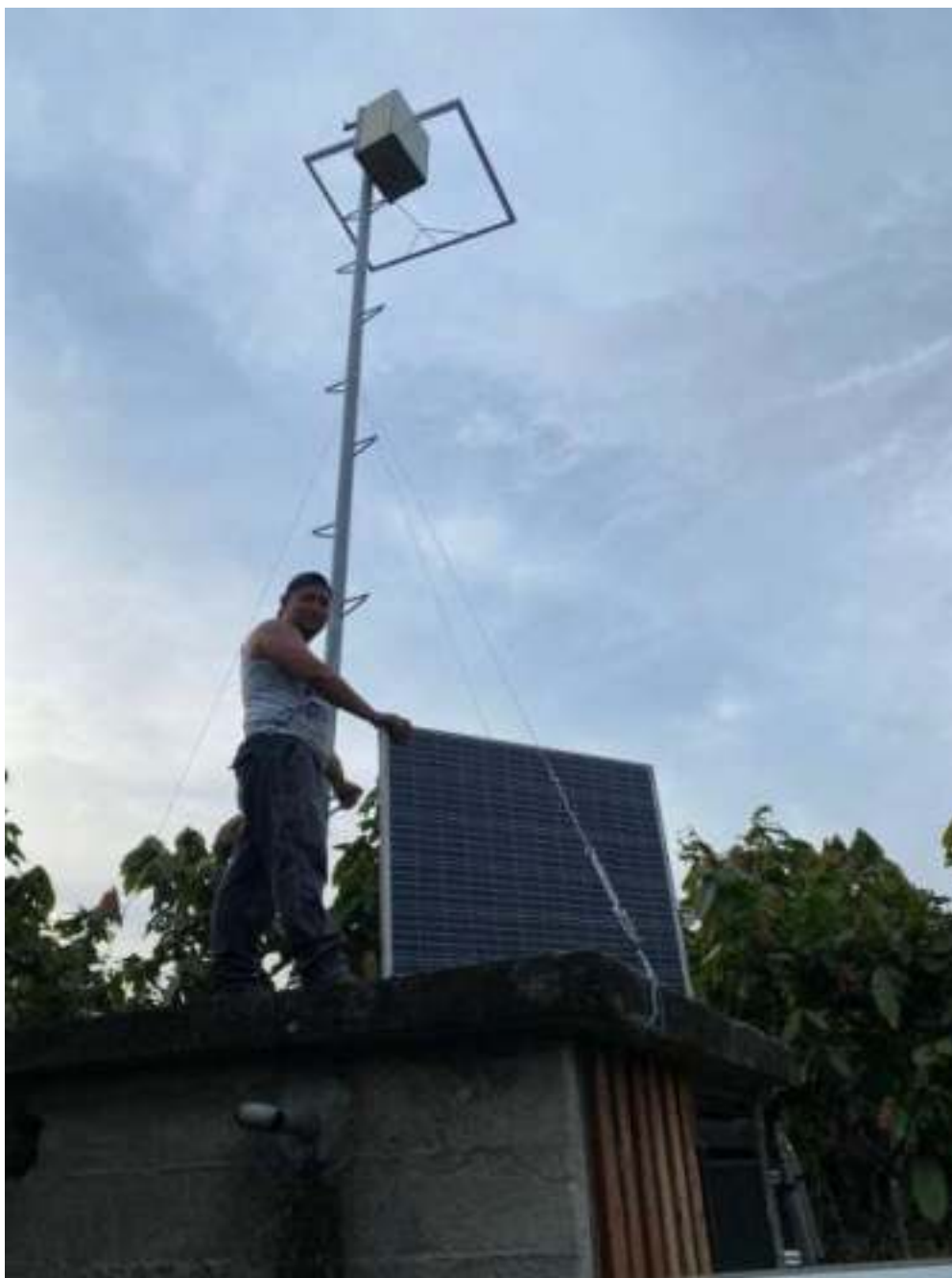
Figura 23. Realizando la instalación de los equipos en la finca - 1 Silva y Soto, 2023
