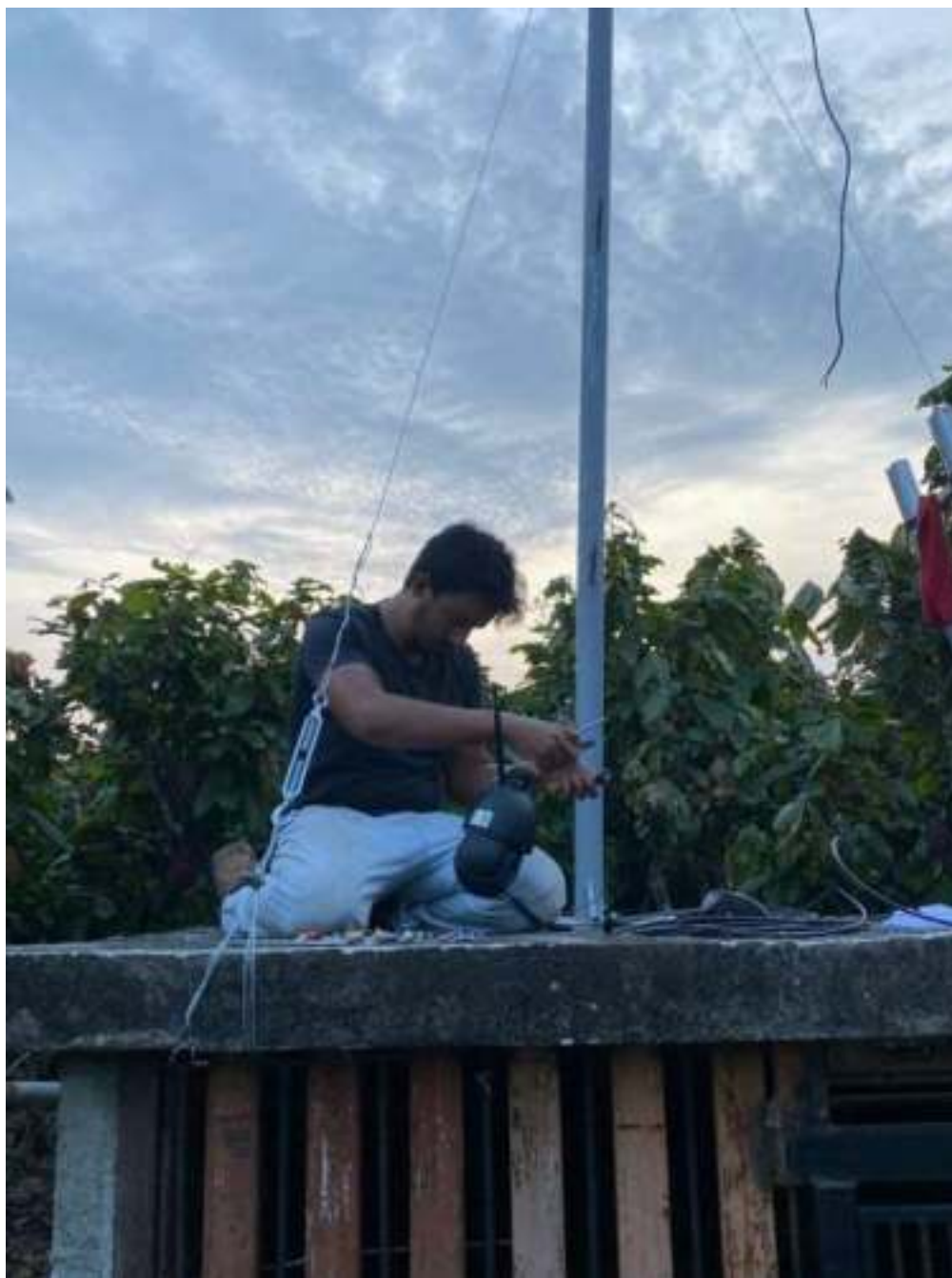
Figura 24. Realizando la instalación de los equipos en la finca - 3 Silva y Soto, 2023
