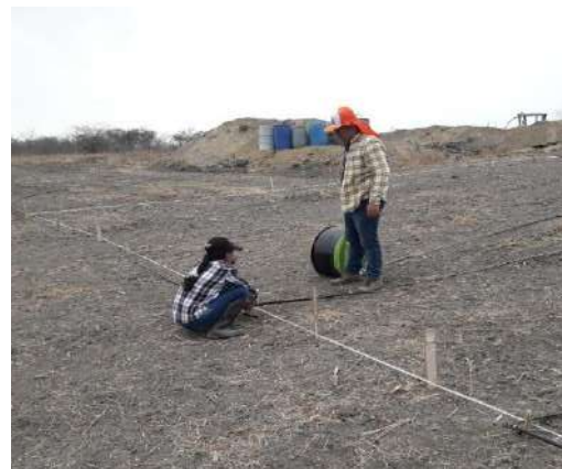
Figura 23. Instalación del riego por goteo Sailema, 2021
