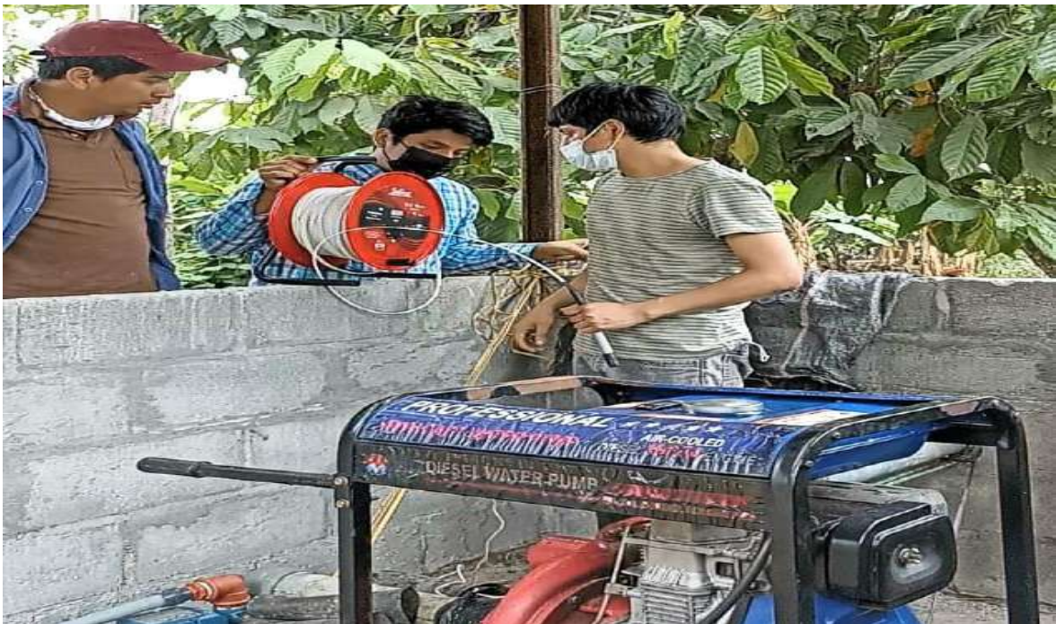
Figura 28. Prueba de bombeo del productor Martita 1 Sagñay, 2022
