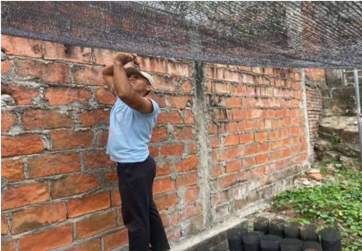
Figura 17. Construcción del vivero. Quinde, 2024
