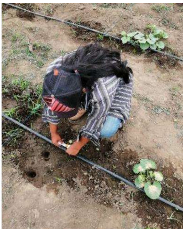
Figura 17. Instalación del sistema de riego. Pin, 2021
