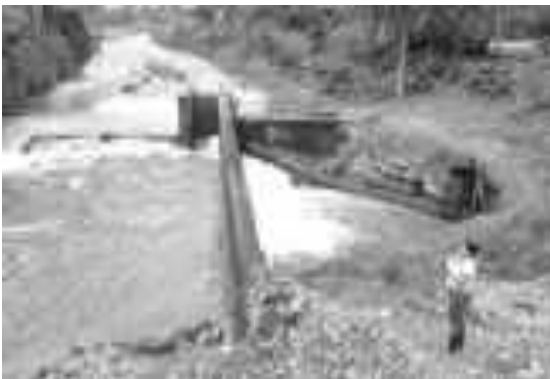
Figura 26. Captación B Pesántez, 2021
