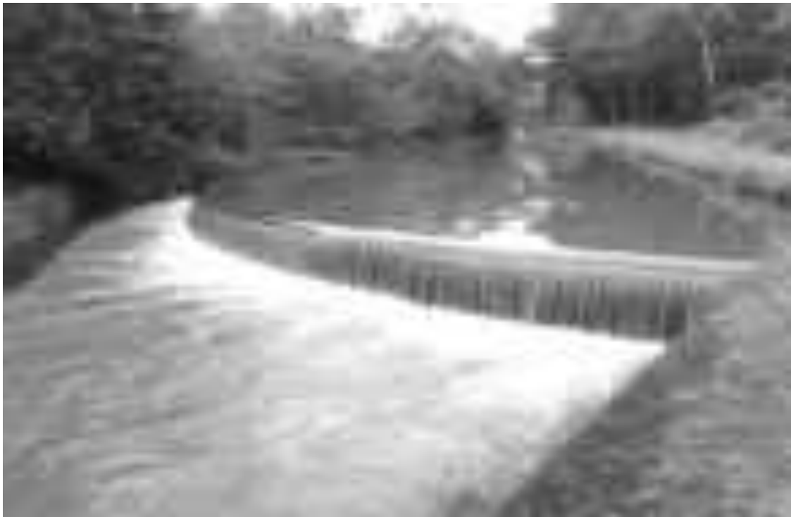
Figura 27. Vaso desarenador que desemboca al canal principal Pesántez, 2021
