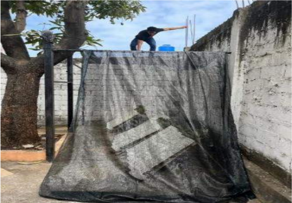
Figura 12. Colocación de malla sombra. Méndez, 2023
