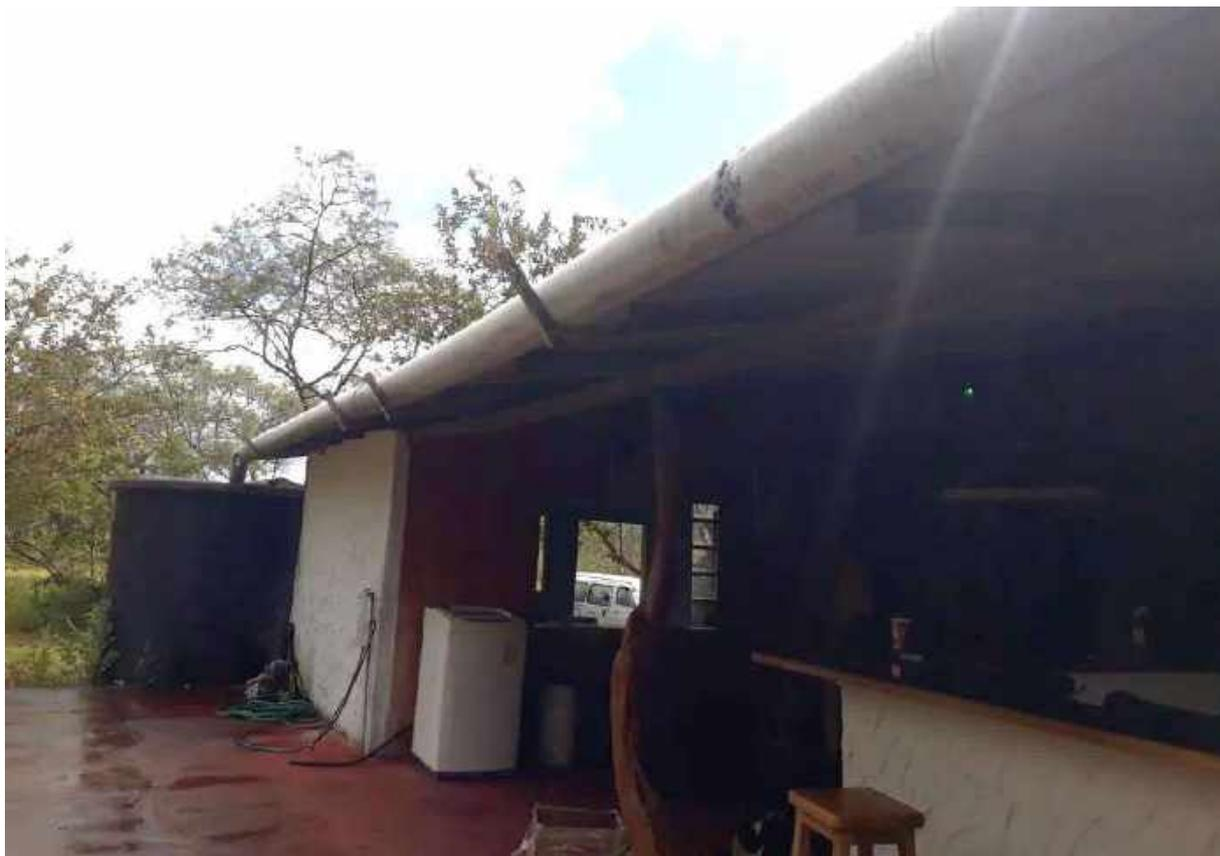
Figura 20. Recolección de agua de lluvia mediante canaletas.
