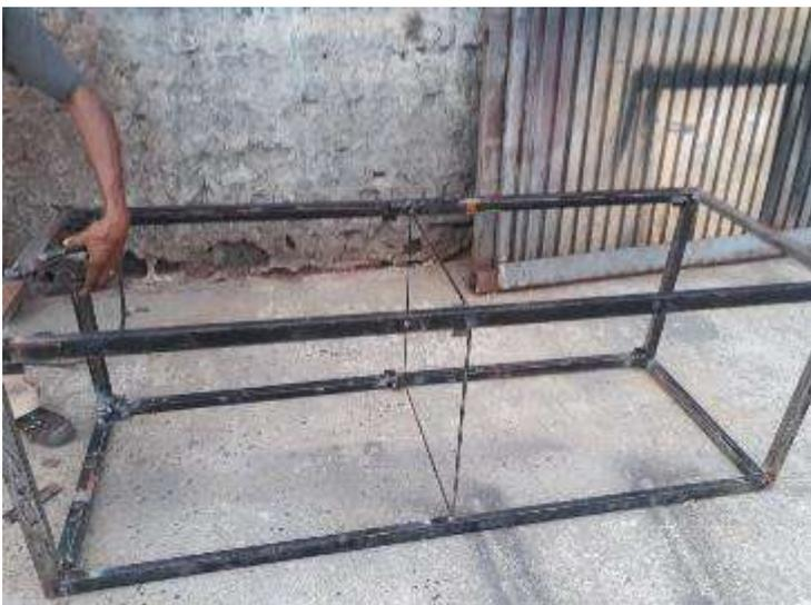
**Figura 53. Estructura del Contenedor**
