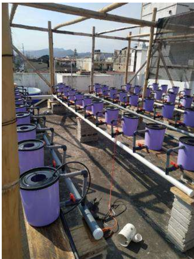
Figura 37. Armado de la estructura y el sistema hidropónico Jiménez, 2020
