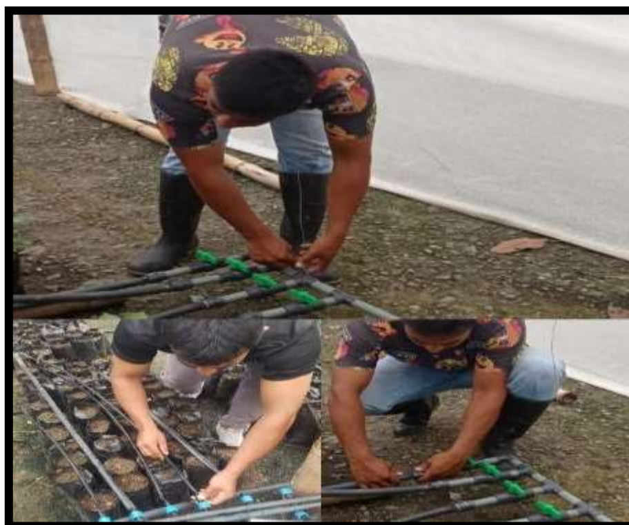
Figura 16. Instalación de riego
