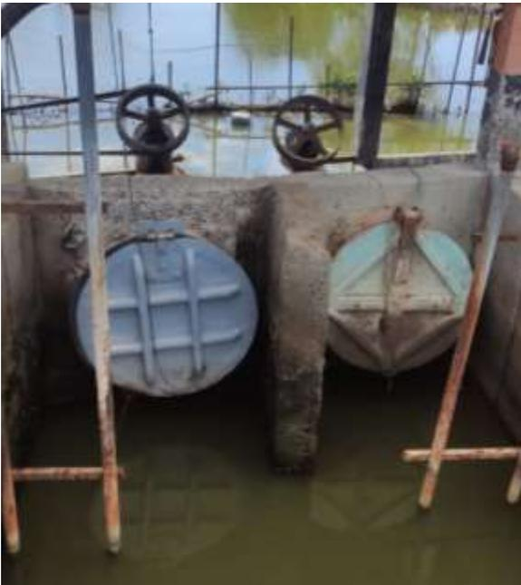
Figura 11. Compuerta de ingreso de agua al reservorio
