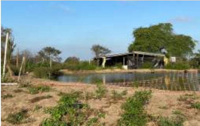
Figura 9. Falta de las barreras de seguridad en los reservorios de agua para el riego Haro, 2021
