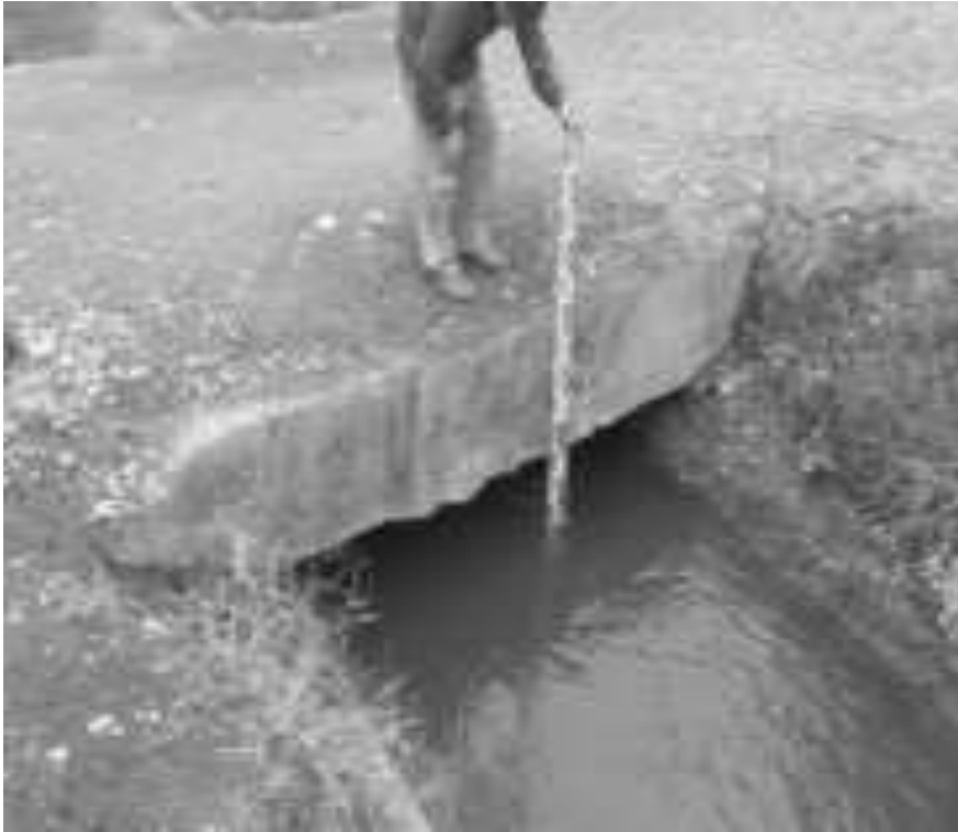
Foto N° 3. Levantamiento de la sección transversal del canal de riego 2-2-1 C Fuente: El Autor, 2021.
