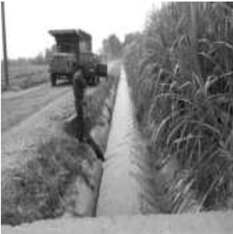
Foto N° 11. Levantamiento de detalle de las compuertas en canal de riego 2-4-C 1 Fuente: El Autor, 2021.
