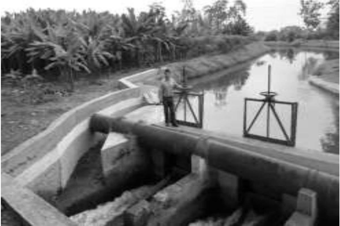
Foto N° 12. Ubicación las compuertas al final del canal San Antonio e inicio del estero Anapoyo. Fuente: El Autor, 2021.
