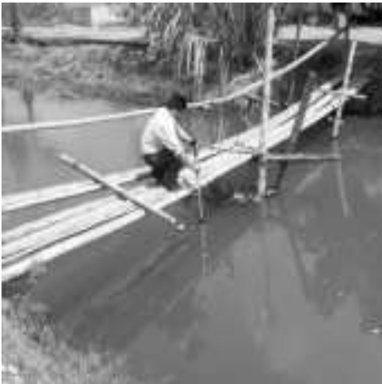
Foto N° 9. Levantamiento de la sección transversal del canal de riego M-1 y aforo. Fuente: El Autor, 2021.
