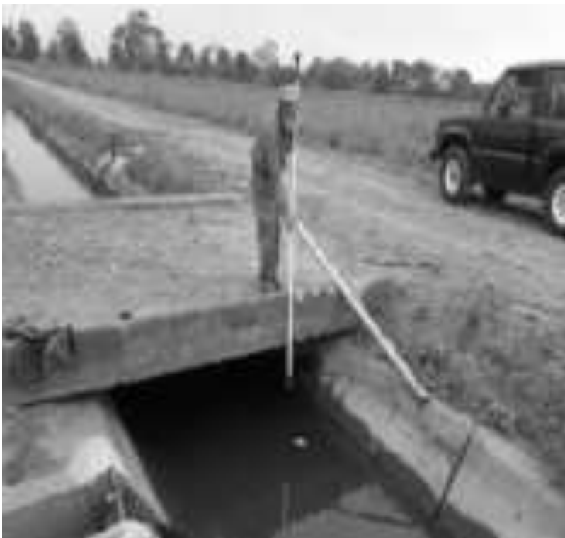
Foto N° 4. Aforo del canal de riego 2-2 C Fuente: El Autor, 2021.
