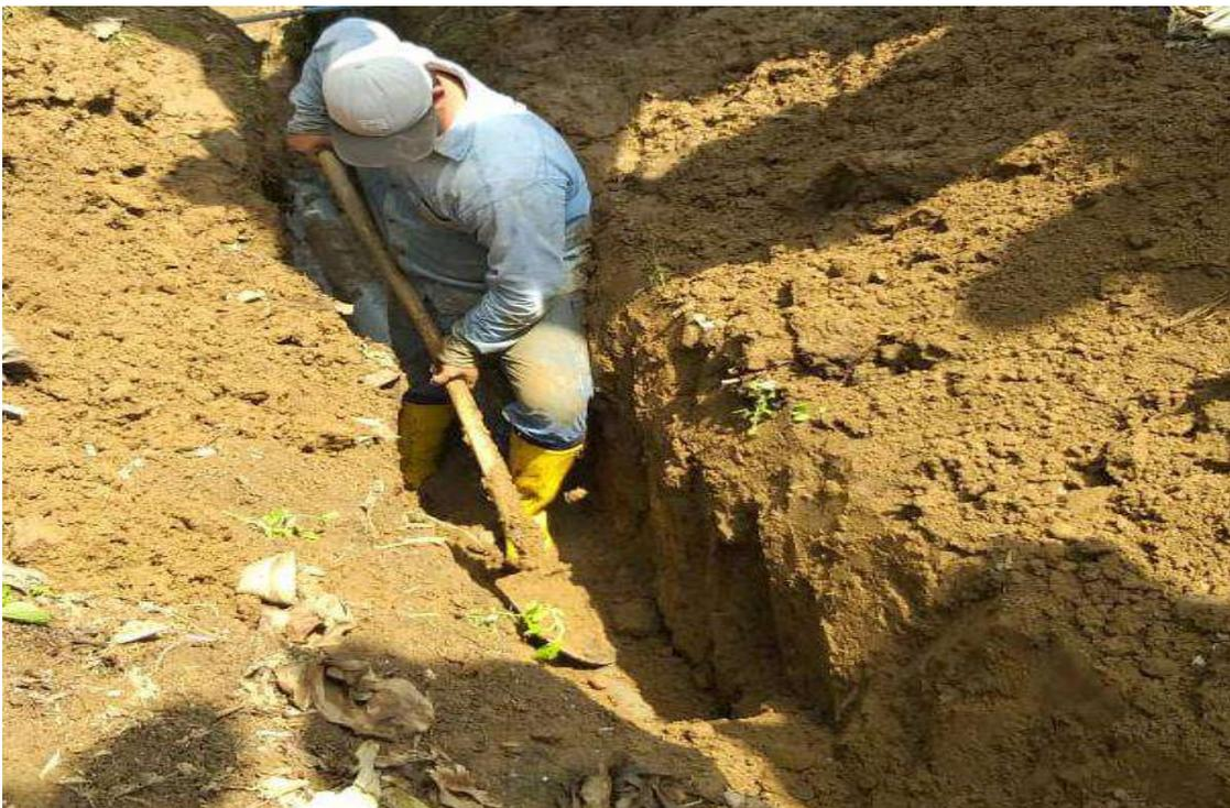
Figura 26. Zanja profundizada para la tubería principal
