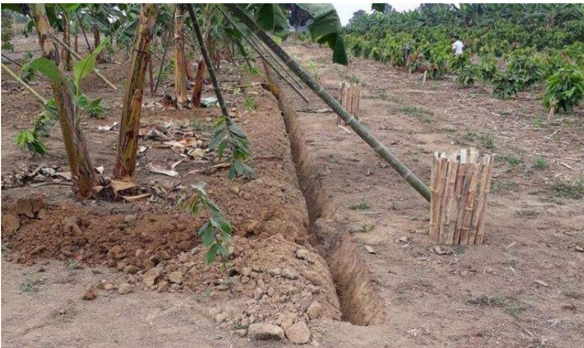
Figura 17. Zanja para la tubería principal
