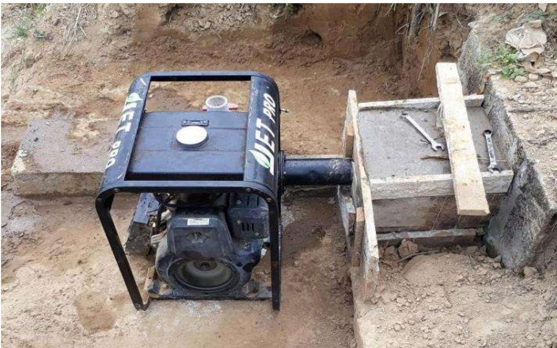
Figura 13. Instalación de bomba de 10 hp con su descarga
