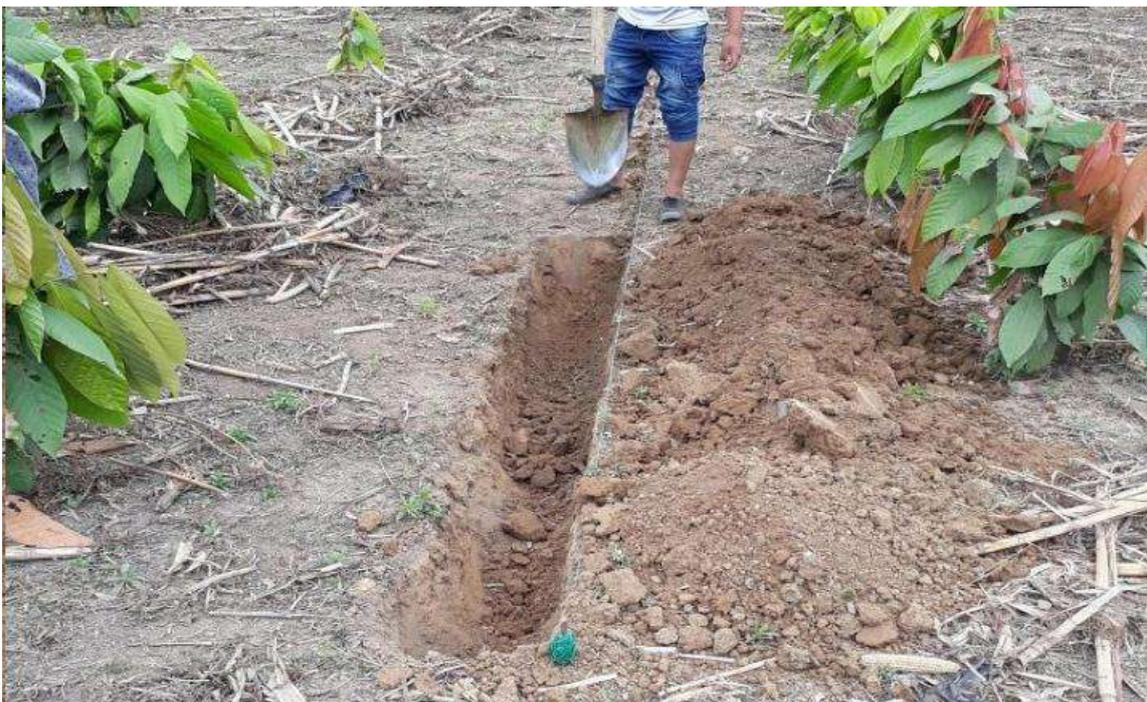
Figura 15. Zanja para tubería secundaria
