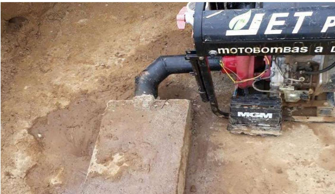
Figura 14. Instalación de bomba de 10 Hp con su succión
