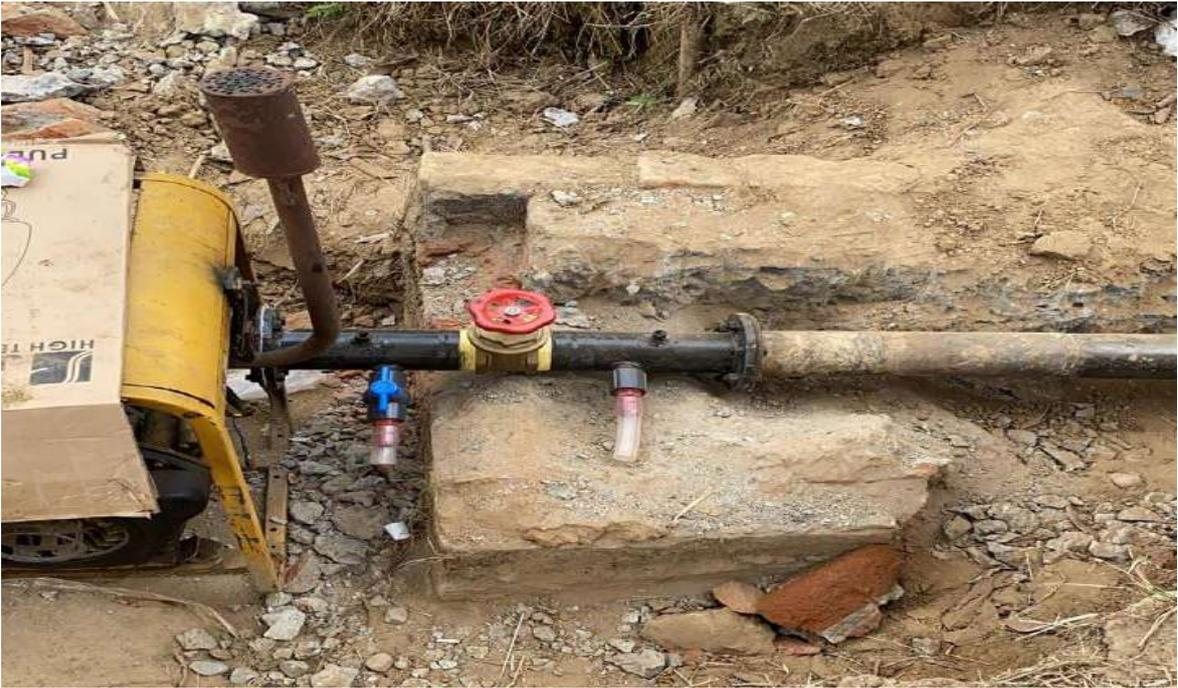
Figura 27. Instalación del inyector Venturi
