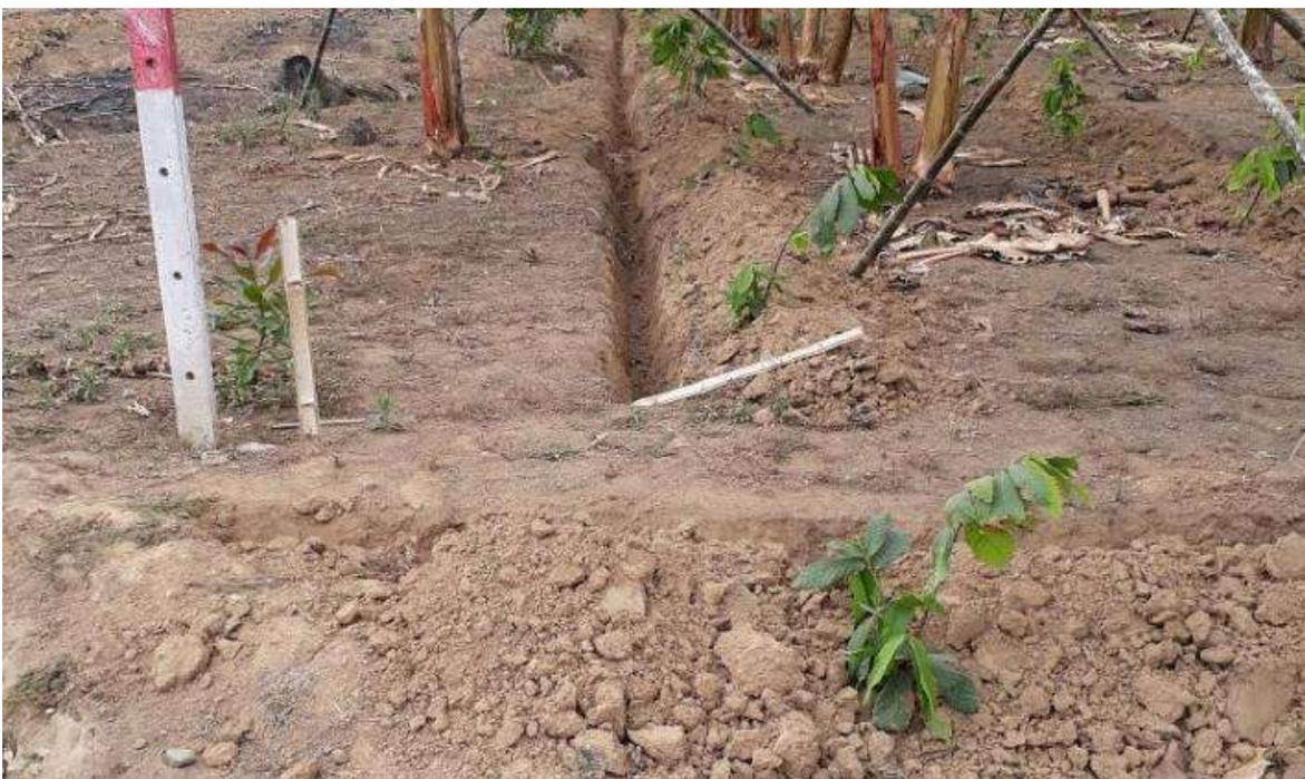
Figura 18. Zanja para tubería terciaria
