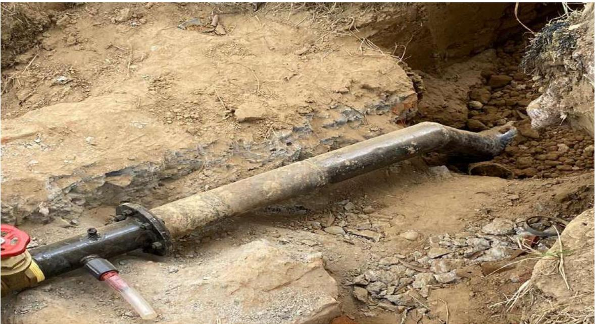
Figura 28. Instalación del inyector Venturi
