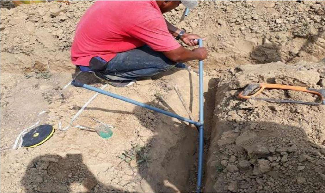
Figura 21. Instalación de tubería terciaria y pegado de levadores
