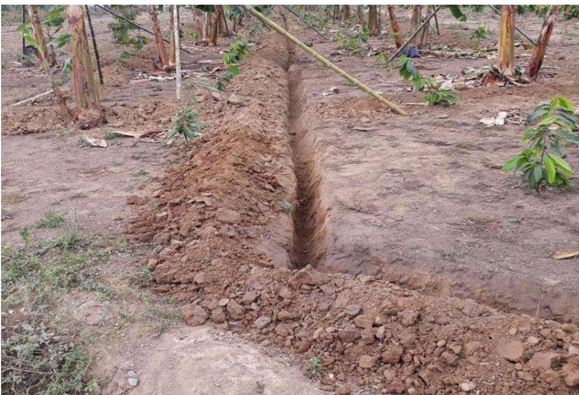
Figura 16. Zanja para la tubería conductora
