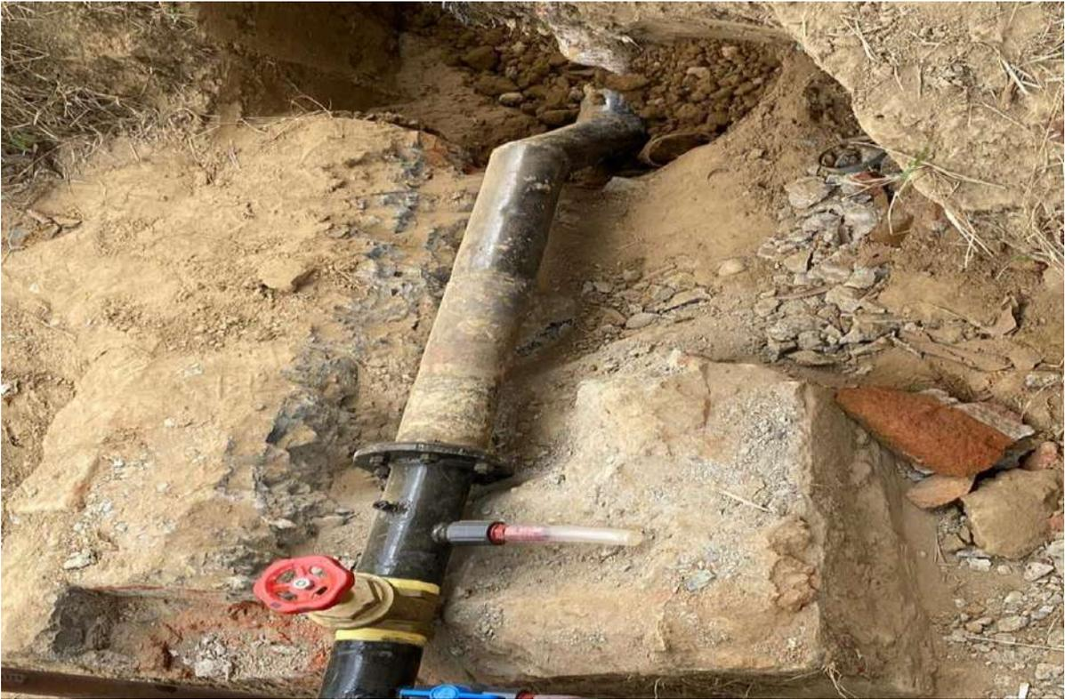
Figura 29. Instalación del inyector Venturi
