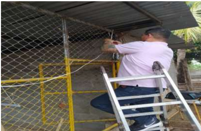
Figura 47. Instalación de cableado eléctrico. Briones y Córdova, 2021
