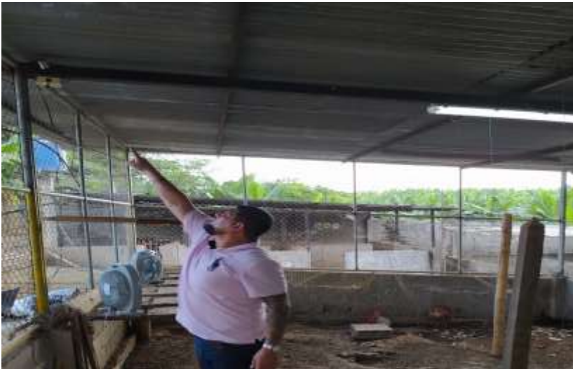
Figura 46. Instalación de sensor de temperatura y humedad, y ventiladores Briones y Córdoba, 2021
