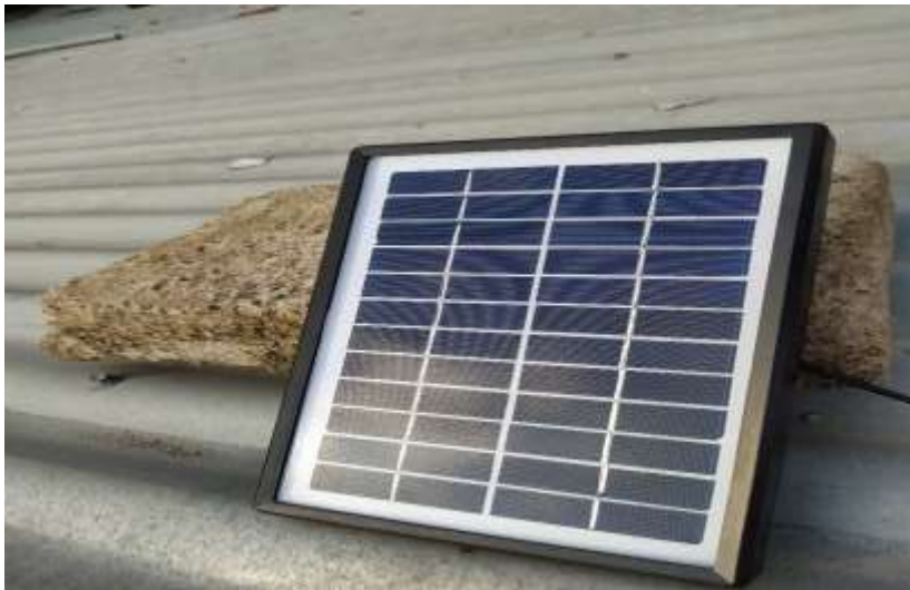
Figura 52. Instalación de panel solar Briones y Córdova, 2021
