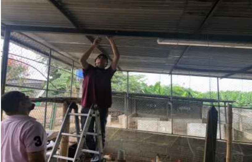
Figura 45. Instalación de luces Briones y Córdoba, 2021
