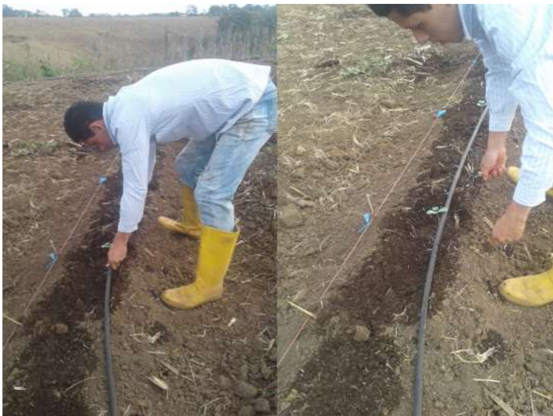
Figura 25. Instalación del riego por goteo Burgos, 2020
