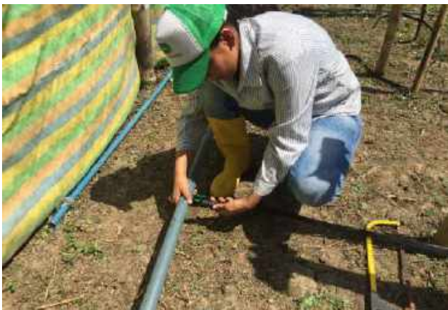
Figura 49. Instalación del sistema de riego. Burgos, 2020
