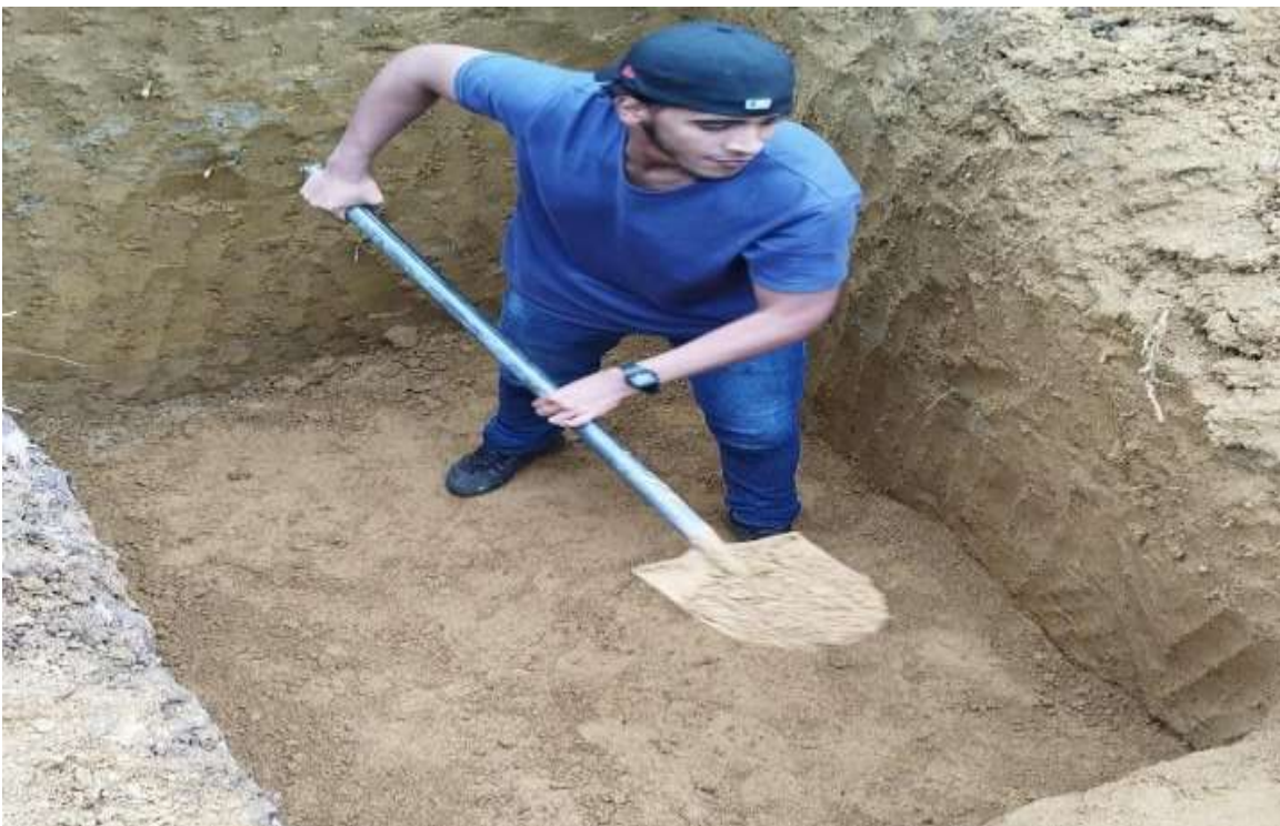
Figura 17. Ubicación y realización de la calicata Barcia, 2024
