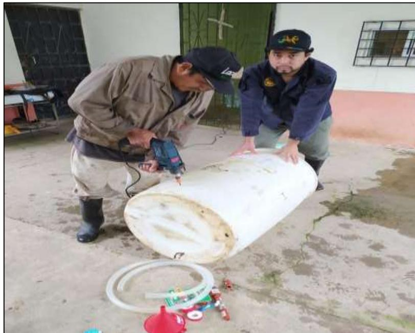
Figura 22. Realizando orificios de media pulgada para extracción de digestato
