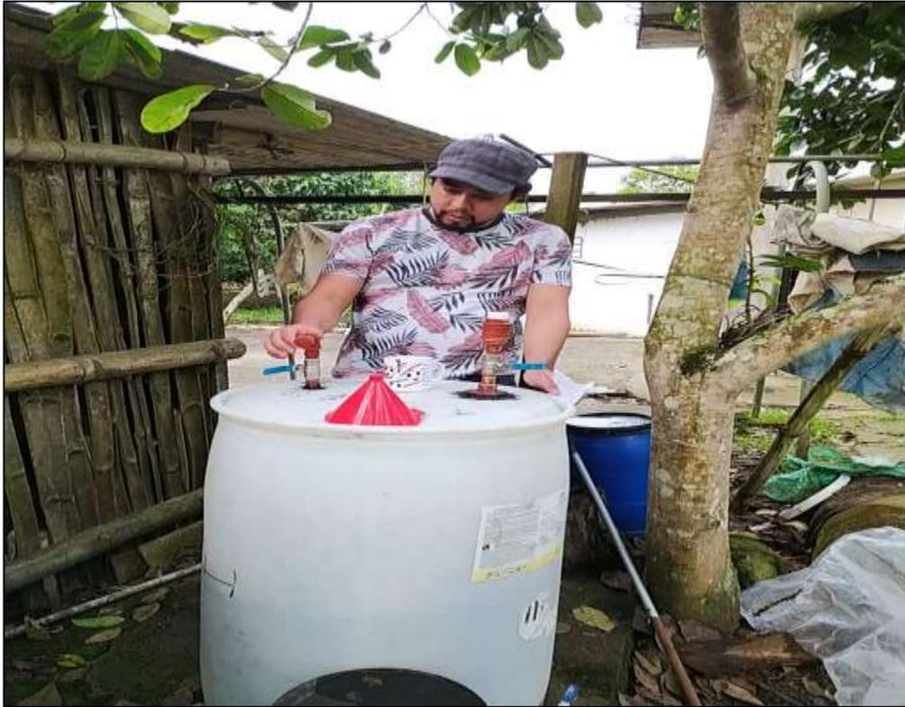
Figura 23. Acople de neoplos y tapones para la parte superior del Biodigestor
