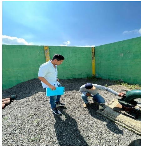
Figura 6. Visualización del pozo de captación
