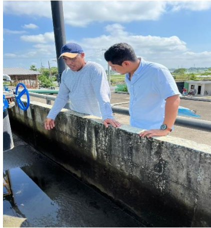
Figura 11. Salida de lodos de retrolavado (arena proveniente del pozo)
